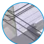
Traseu de agent frigorific cu 3 conducte
